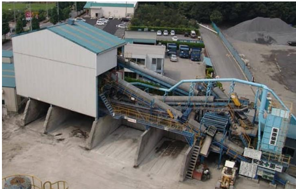
(再生砕石プラント)
